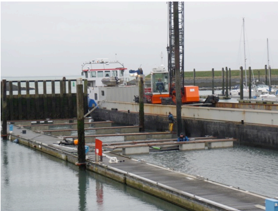
20 februari 2014 - Monteren vingerpielen en plaatsen palen
